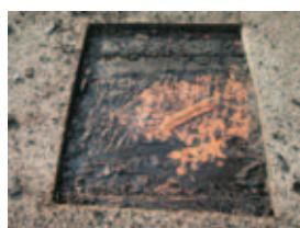
● ビスの引抜き試験のため、既存防水(砂付露出アスファルト)を剥いだ様子
