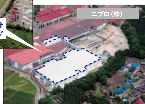
当物件は注射器や医薬品などの生産工場であり、建築については細心の注意がはらわれた。屋根工法についても然りであり、二重防水になるという考え方から、新築物件にも関わらず折板の上に断熱シート防水という重厚な工法が採用された。また、現在(平成20年10月現在)増築中の物件にもリベットルーフが採用される予定である。
