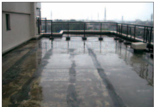
改修前:保護コンクリート仕上げアスファルト防水
