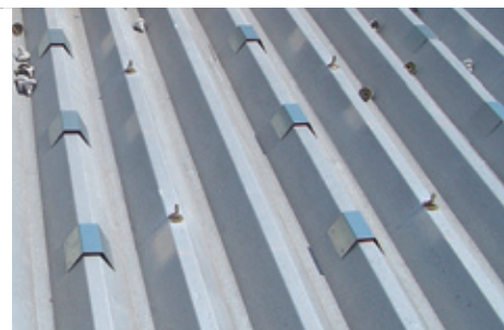
IHディスク固定のため補強鋼板を使用
