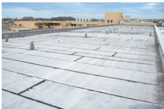
既存防水: アスファルト
