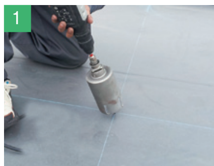
1 リベットルーフ・断熱材のコア抜き
