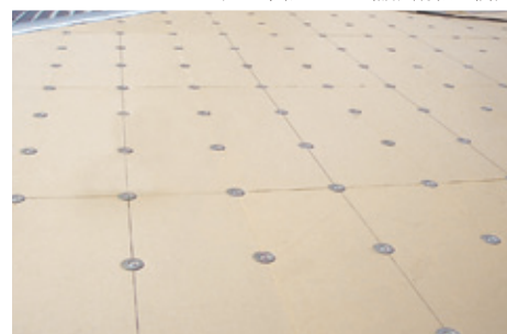
断熱材敷設・IHディスク固定
