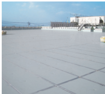
耐火断熱サンドイッチパネル敷設
