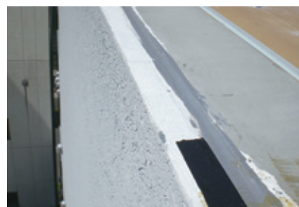
外壁断熱改修(別工事)
