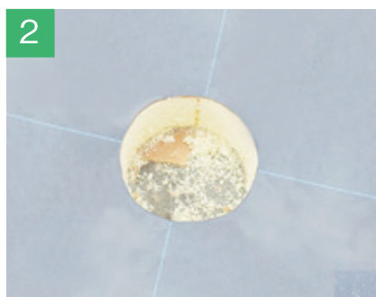
2 リベットルーフ・断熱材のコア抜き後
