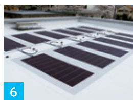
リベットルーフソーラーシート設置完了
