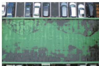
施工前(露出アスファルト+トップコート)
