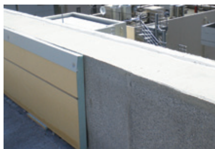
立上り断熱材設置
