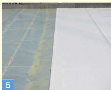
5 リベットルーフを張り込み
