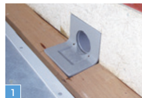
1 下地を取付け
