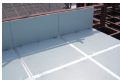
立上りにFLボードNPを敷設。ジョイント部はALジョイントテープ(アルミテープ)にて処理。
