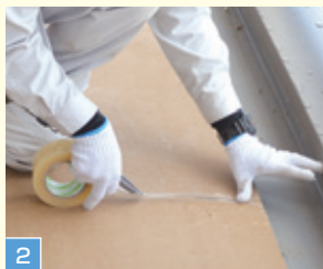
2 AYパネルVの敷設 ※AYパネルVはカッターで加工可能です。
