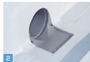
2 リベットルーフを施工
