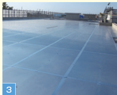
3 FLボードMSの目地部にALクロステープを貼付け
