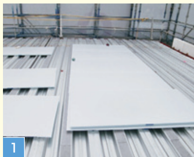
1 FLボードMSの敷設
