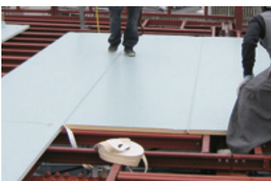
鉄骨下地にFLボードNPを敷設。
