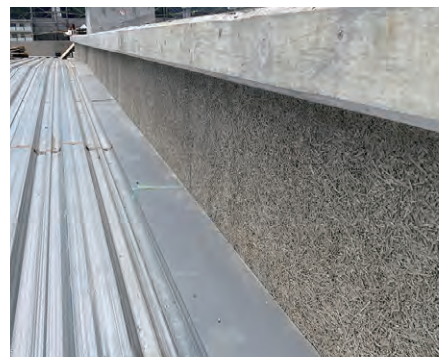
立上りは風の吹き込みを防止するため、木毛セメント板を設置し、下地処理を行い、接着工法で納めています。
