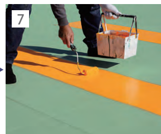
7 ルミノヘリサイン(中塗り)を重ね塗り。さらに16時間乾燥させる。
