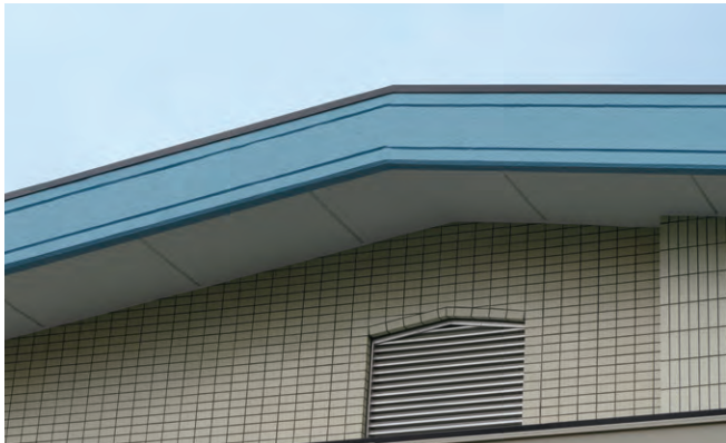
ケラバに取り付けられたFL鋼板ブラック。
