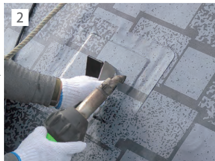
2 リベットルーフARTを加工した増張りシートを溶融着接合。
