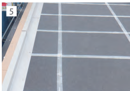
5 FL鋼板の固定。
