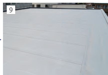
9 リベツルーフ接合部を溶融着し、完成。
