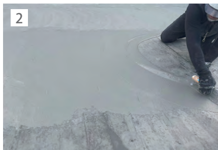
2 既存塩ビシート防水下地を撤去し、下地調整。
