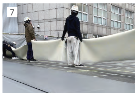
7 リベツルーフを張り込み、シートを転圧。
