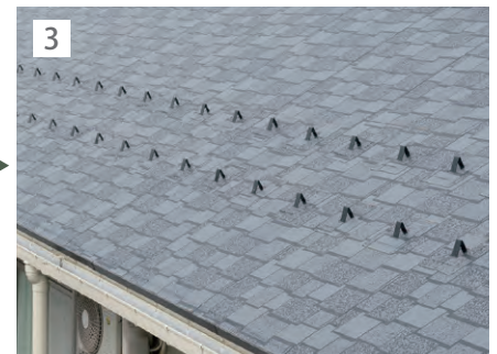
3 FLシーンを充填し、完成。
