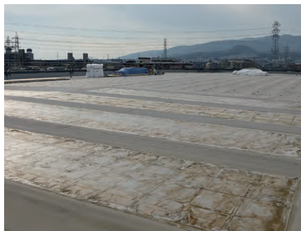
屋上緑化設備を撤去後。
