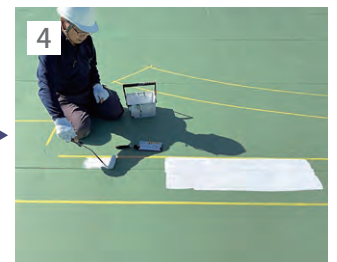
4 ブラシールプライマーを塗布し、24時間以上乾燥させる。
