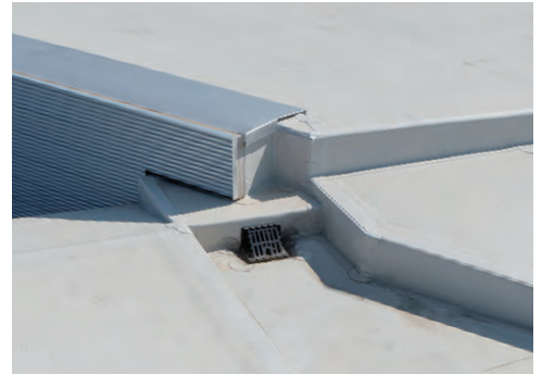
勾配で生じた段差部の納まり。
