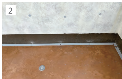
2 IHディスク、FL鋼板を設置。
