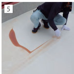
5 アキレスボードGFとシートの両面にAYボンド580NFを塗布。
