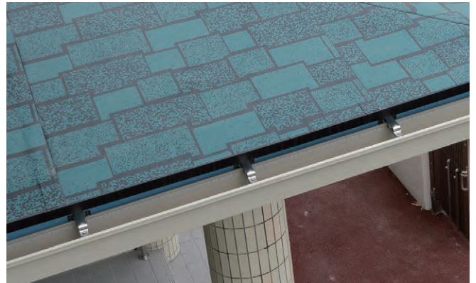
軒先にもFL鋼板ブラックを使用。
