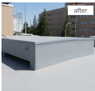
水切りを撤去し、平場からシートで覆うように立上り面を防水施工。
