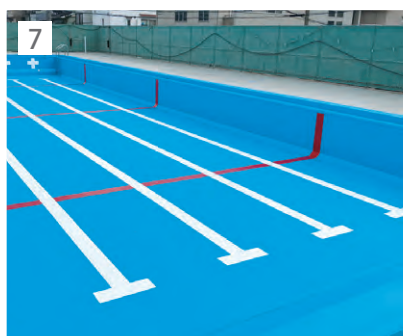
7 ラインテープ、表示シートを施工。
