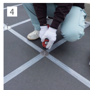
4 AY固定ディスクでアキレスボードGFを固定。端部にFL鋼板を設置。
