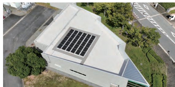
同時に防水改修と太陽光設備設置を行った給水施設棟。
