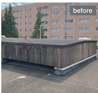
水切りを撤去し、平場からシートで覆うように立上り面を防水施工。
