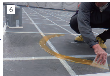
6 アキレスボードGF上面とシート裏面にAYボンド580NFを塗布。
