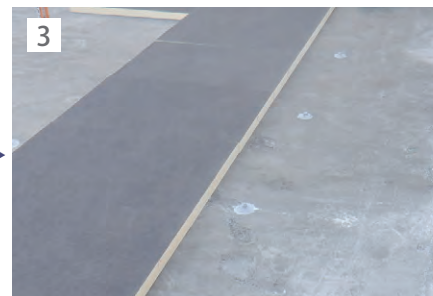
3 ネダジャンボを塗布し、アキレスボードGFを敷設。
