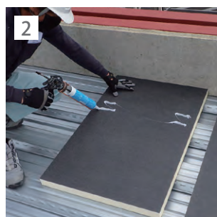
2 耐火デッキプレートとアキレスボードGFに専用ボンドを塗布。
