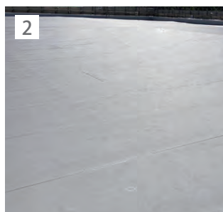
2 リベットルーフを敷設し、IH断熱ディスクとシート同士を溶融着接合する。
