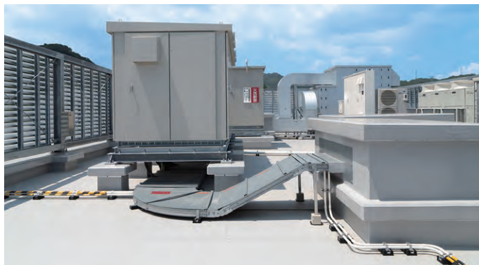
コンクリート基礎部はアゴ下までシートを巻き上げ、頭部はウレタン防水を併用しています。
