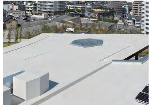
エントランス屋根部。
