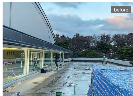
防水改修前の様子。
