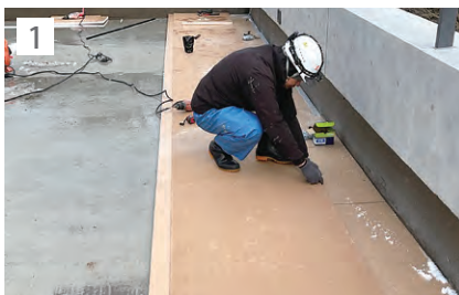
1 FLボードSとAYパネルVを敷設。
