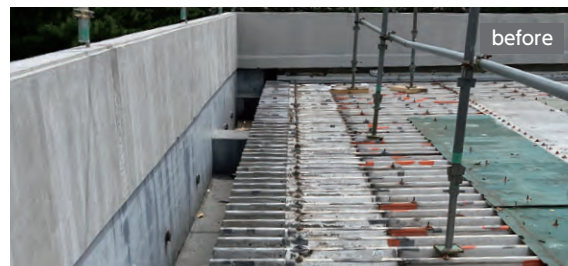
既存折板屋根。塩ビシート防水撤去後。
