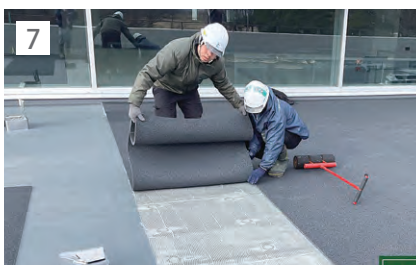
7 クッションマットを敷設。
