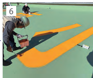
6 文字部にルミノヘリサイン(中塗り)を塗布する。2時間乾燥させる。
