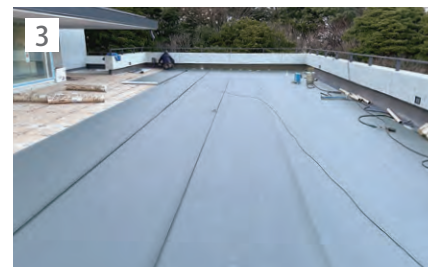
3 リベットルーフを張り込み。
