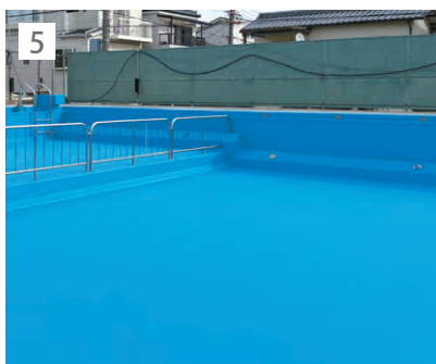
5 平場部：AYプールシートGを敷設。シート同士を溶融着接合。
