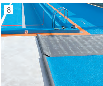
8 コリドールを敷設。位置合わせを行いカット。
