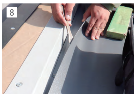
8 リベツルーフとFL鋼板の溶着接合。
