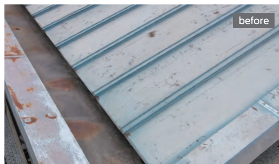
既存瓦棒屋根。
