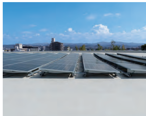
低設置のため、クリアランス幅350mmでも太陽光モジュール上に影が落ちない設計です。
