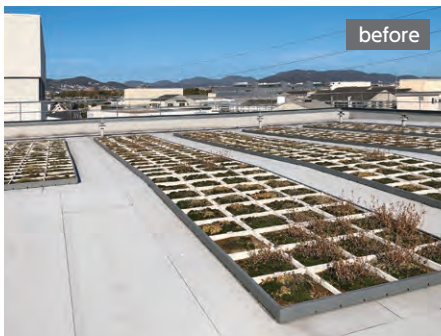
改修前の様子。
