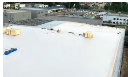
同年9月18日。大屋根の大半の部分でリベットルーフが施工されている。
