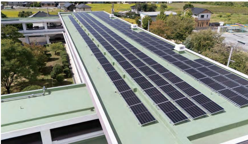
北側校舎屋上。段差を伴う島状の平場構成により、モジュールを低設置とすることで、風圧や景観への影響を抑えています。
