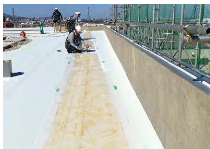
シート裏側への風の吹き込みを抑制。
