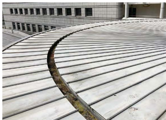
既存防水層は放射状リブ構造の金属屋根材。
