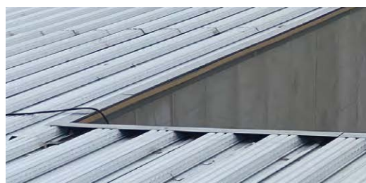
(上)軒先部とケラバ部の仕上り。(下)下地鋼板の施工途中。
