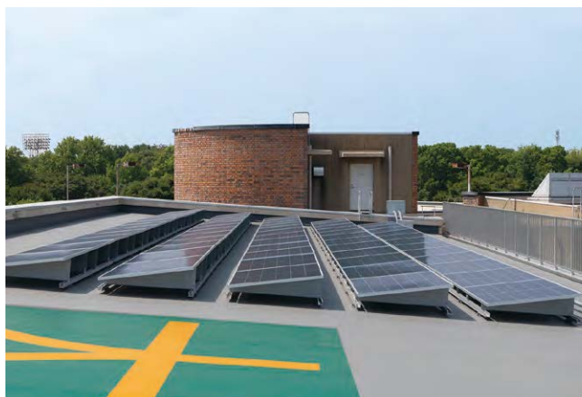
南側屋上。1/15の勾配が設けられており、メンテナンスを考慮し、水下側に手すりを新設。
