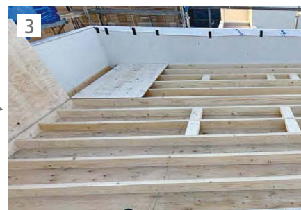
3 垂木に対して防水下地となるボード材を固定し、適切な勾配を設けます。
