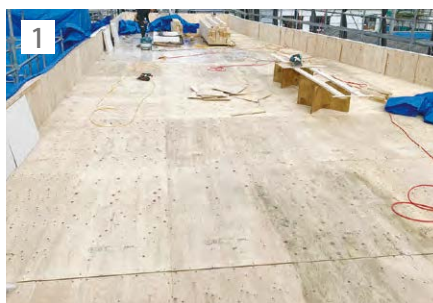
1 屋上下地面の工事が完了。
