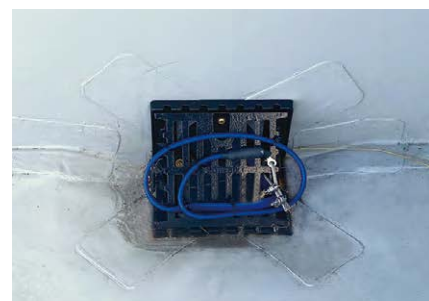
ドレン部には電熱ヒーターを設け、冬期の排水性を確保しています。
