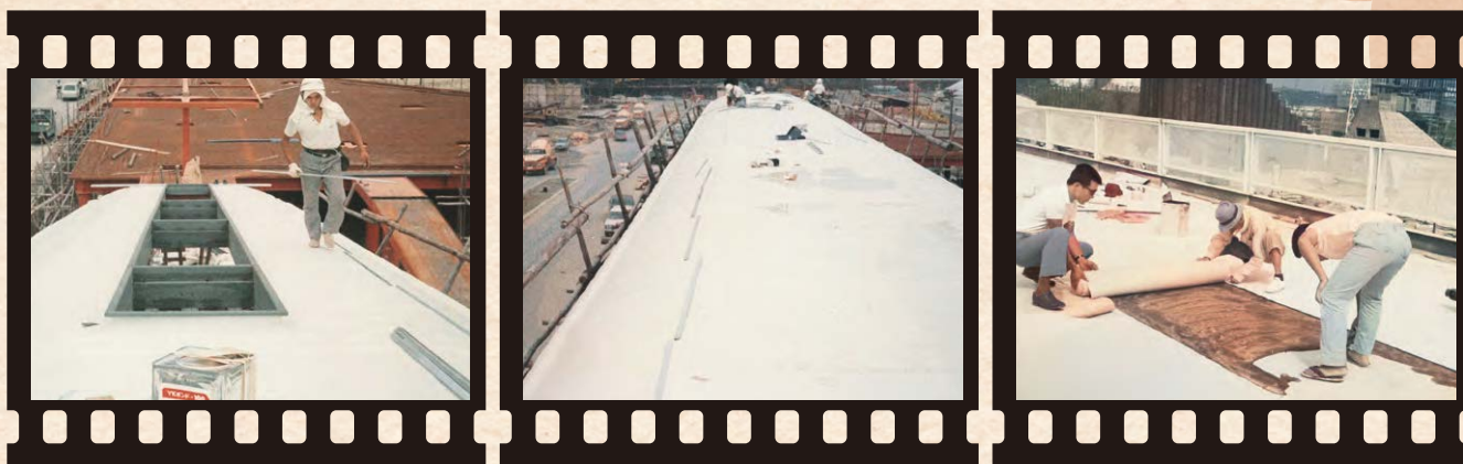
接着工法による塩ビシート防水の施工。(1970年 日本万国博覧会会場)
