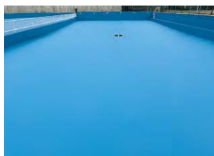
防水シートの張り込み。シート相互や、固定金具を溶融着接合。
