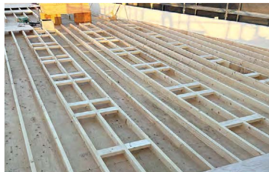
連結ディスクADCの配置に合わせて、垂木を配置している様子。
