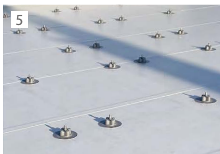
5 垂木に対して、連結ディスクADCをアンカー固定、リベットルーフと溶融着接合。
