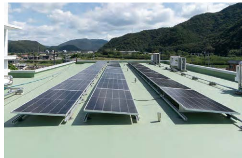
南側校舎屋上。メンテナンス通路を兼ねたスペースに脱気筒を設置。太陽光設備だけでなく、建物の長寿命化のために躯体の健全化にも配慮しています。
