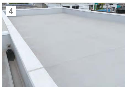
4 リベットルーフ接着工法で防水施工。
