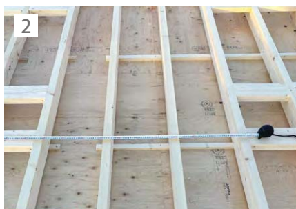
2 垂木を連結ディスクADCの配置に合わせて設置。
