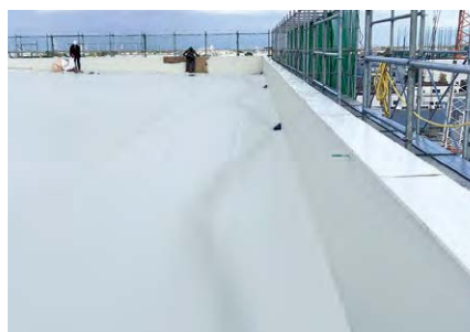
パラペット際に勾配を設け、雪解け水の停滞を防止。凍結による劣化リスクを軽減しています。
