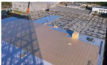
同年9月9日。デッキプレート下地が敷かれた部分から順次、断熱材敷設とリベットルーフを施工。
