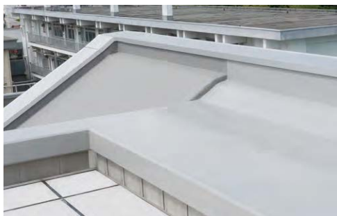
南側底の立上りからウレタン塗膜防水が連続し、勾配屋根でリベットルーフと取り合う構成。
