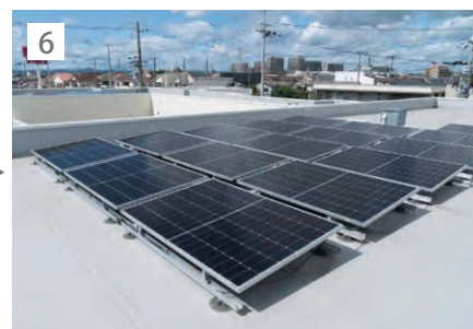
6 EBレール、EB傾斜ラックを組み立て、太陽光モジュールを設置し、完成。
